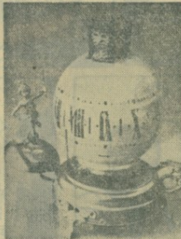
ОВАЈ ЧАСОВНИК ЈЕ ПРАМАЈКА НАШЕГ ВУДИЛНИКА СА СВЕТЕЉИМ БРОЈЧАНИКОМ. НА ГОРЊЕМ ДЕЛУ ЈЕ ГОРЕО ПЕТРОЛЕЈСКИ ПЛАМЕН И ОСВЕЋАВАО СТАКЛЕНУ КУГЛУ А ДОЛЕ СЕ У КРУГУ КРЕТАЛА КАЗАЉКА И УДАРЛА СВАКОГ САТА У ЗВОНУ
