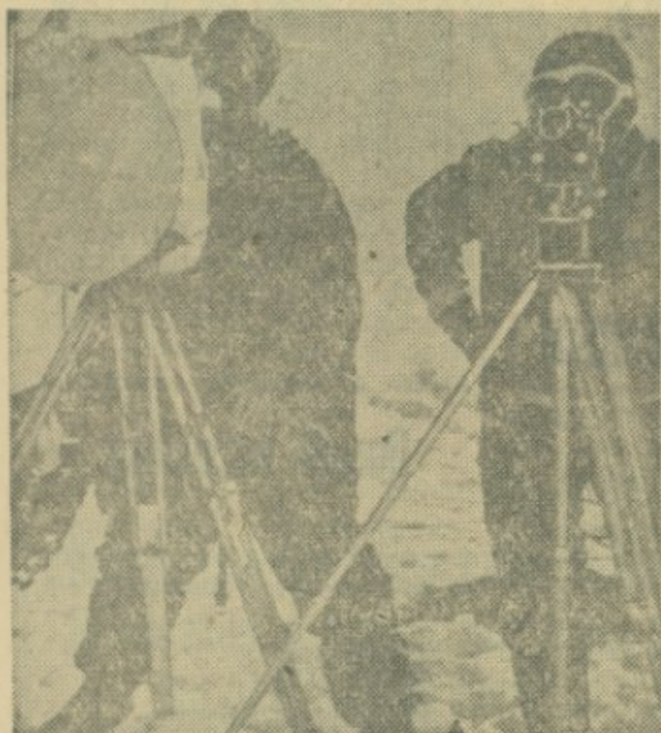
НА ГРЕНЛАНДУ ЈЕ ИСПРОВАН „РАДАР ЗА ЛЕД“. ПОСЛЕ ПОСТАВЉАЊА СПЕЦИЈАЛНИХ ОЗНАКА НА 10 ИЛИ 20 КИЛОМЕТАРА ШАЉУ СЕ СНОПОВИ ТАЛАСА РАЗЛИЧИТИХ ФРЕКВЕНЦИЈА. ЈЕДНО ОГЛЕДАЛО КОЈЕ ПРИМА ТАЛАСЕ У ПЕТОУГАОНИКЕ, ОДБИЈЕ ИХ И БРАТИТИ У РАДАР.
