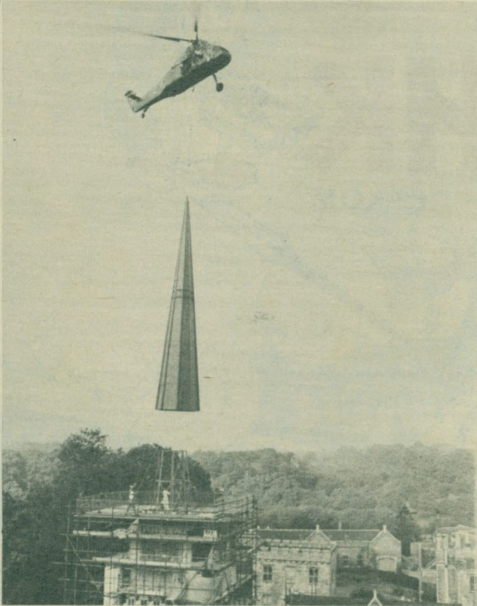
ТОРАЊ С НЕБА. — Стара капела дворца у Ешрицу, у Енглеској, који је касније претворен у школу, добила је нов торањ од фибергласа тежак 2 тоне. Торањ је постављен уз помоћ хеликоптера који је, да би се обавила ова операција, смео да понесе горива само за 15 минута лета.
