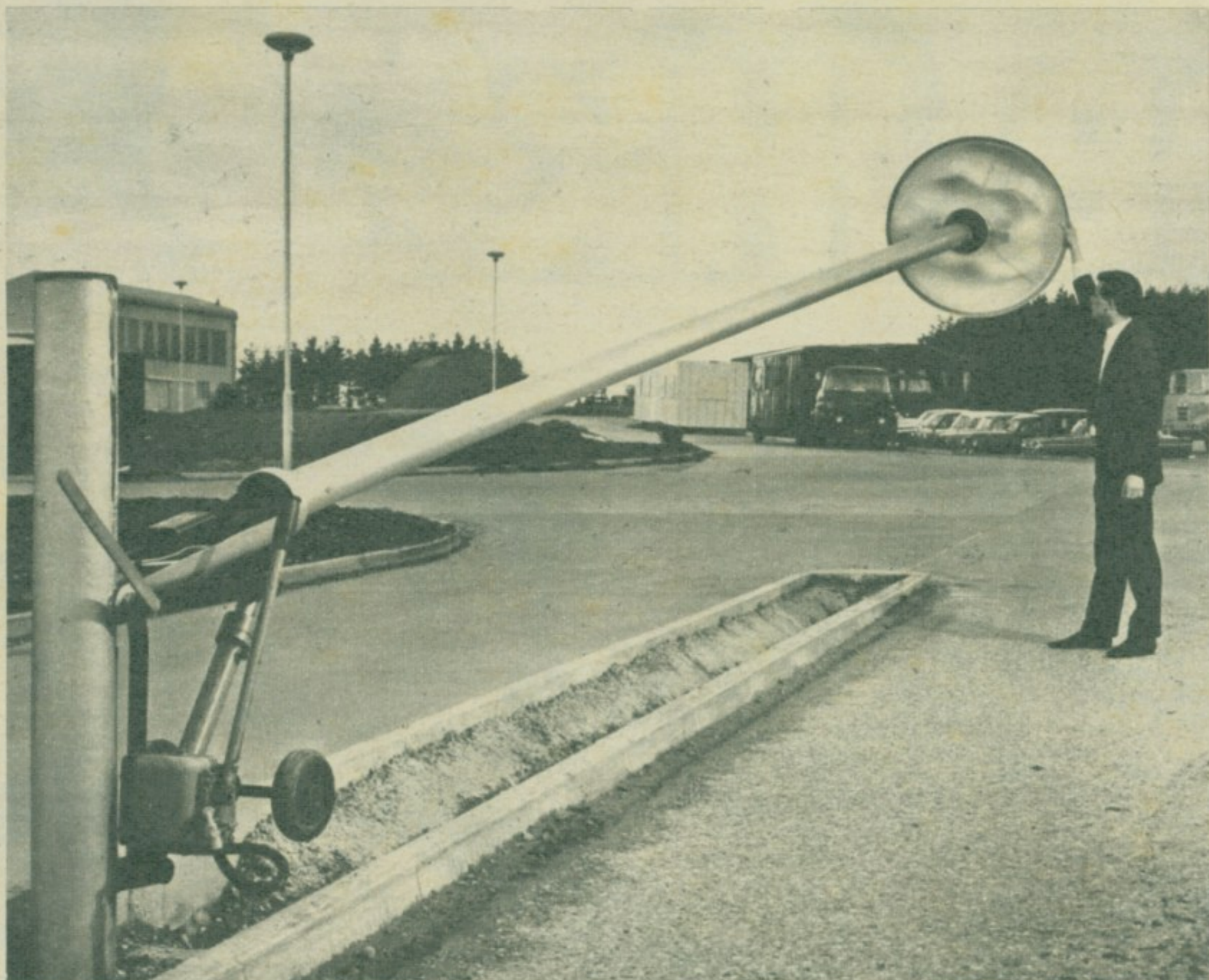
БАНДЕРА НА СКЛАПАЊЕ. — Британски савет за индустријско обликовање усвојио је модел нових бандера за улично осветљавање које поред тога што имају модеран облик, могу веома лако да се одржавају. Бандера се састоји од два дела, спојених шаркама, од којих је доњи краћи. Помоћу малог хидрауличног уређаја горњи део банделе може се оборити у вертикалан положај. На тај начин замена прегорелих сијалица, као и префарбавање старих бандера, обављаће се брже и лакше.
