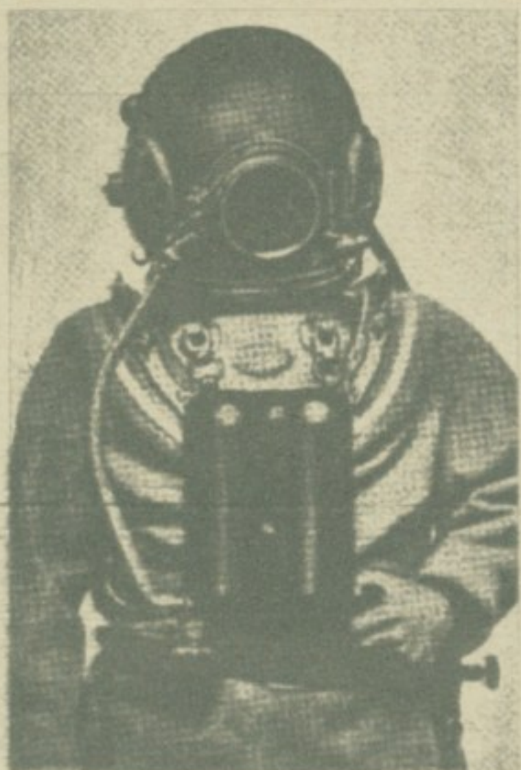
Флеус-Дејвисоног самостални скафандер, један од многих испробаних модела.
