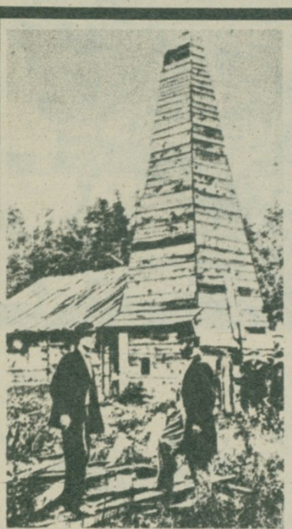
Скела названа „Дерик”, која је држала бушнице на Дрејковим налазиштима нафте
