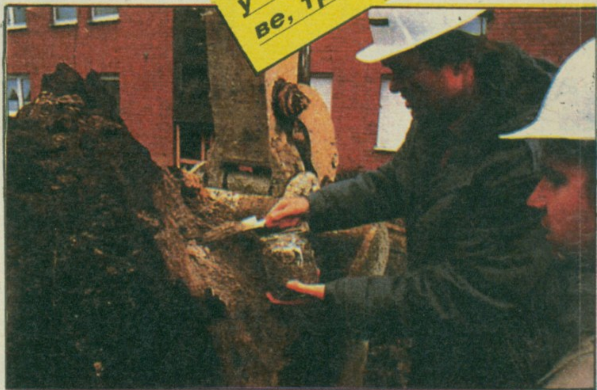
Све почиње узимањем узорака земље до дубине од читавих 15 метара да би се у лабораторији испитало каквих све отрова има у њој.
