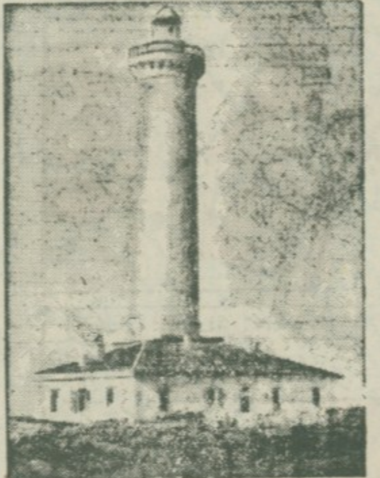
Највећа изаша кула светиља Велират на Дугм Отоку; висина 43 метра, пречник унутра 4 метра, зидови дебљине 1.50 м. Осветљава 25 морских миља око себе
