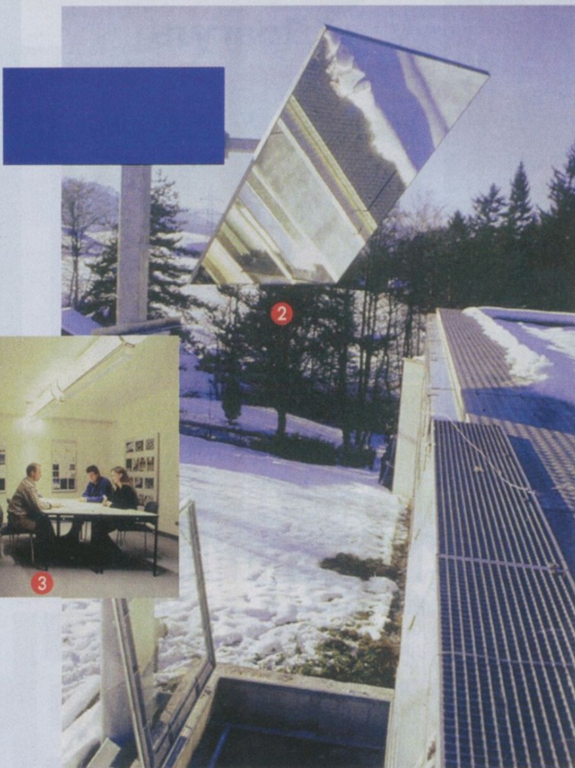
Параболично огледало (1) одбија Сунчеве зраке на друго, мање огледало које их сакупља (2), а затим усмерава на треће. Оно их одбија право у дугачку цев све до подрумских просторија (3)
