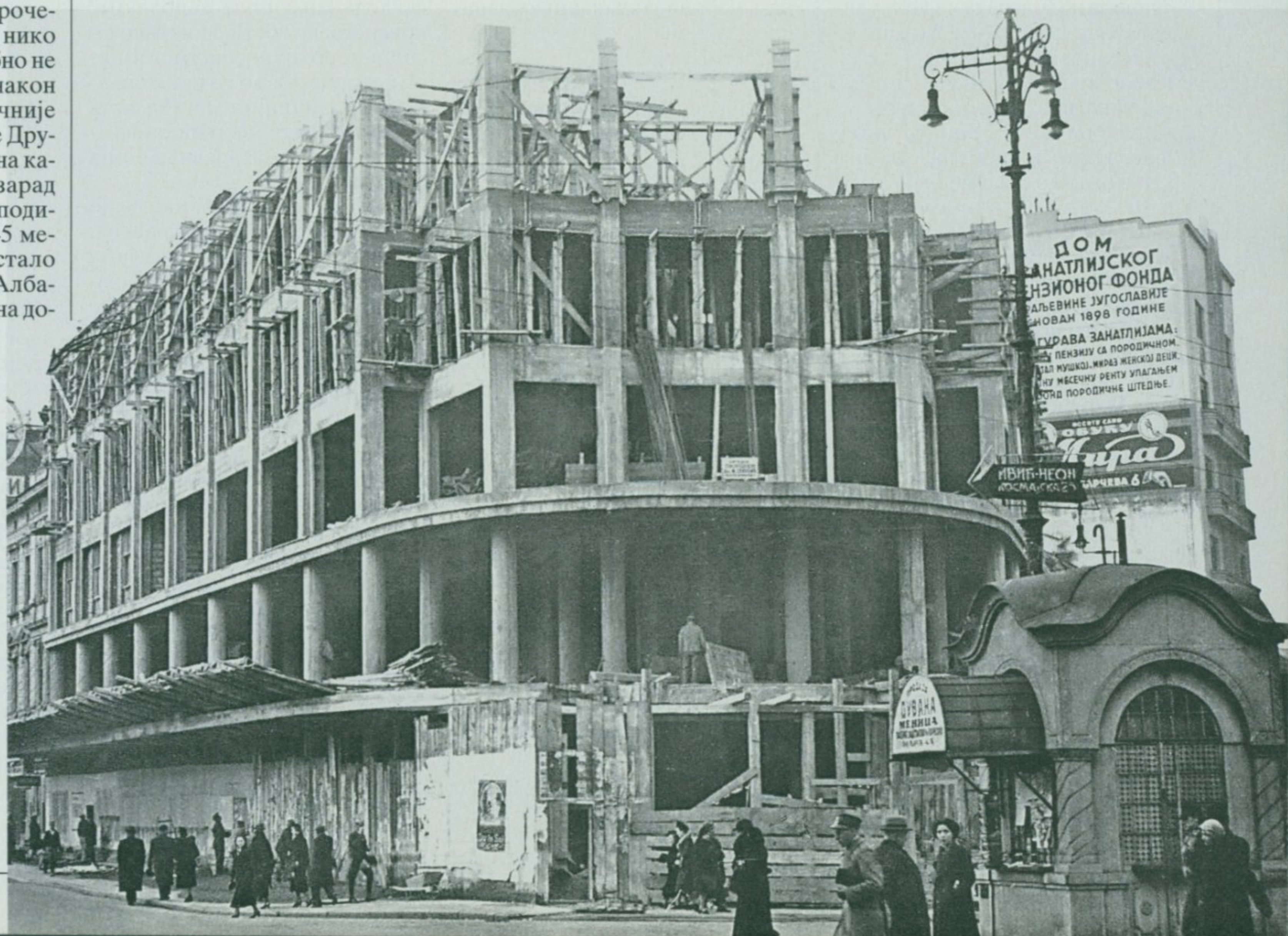
„Албанија” у изградњи почетком 1939. године.
